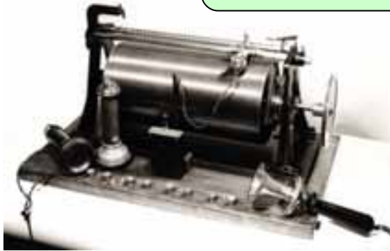
Poulsen の最初の磁気録音機 Telegraphone, 1898 ドラムにワイヤーが巻いてある(らしい?)
